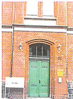
Hier ist deutlich der Unterschied zwischen nur innenliegenden Sprossen (oben) und einer konstruktiven Fenstergliederung zu sehen (unten). Die oberen Fenster wirken kalt, künstlich und billig. Sie sind deshalb in Wernuchen nicht zulässig. Hier müsste sogar ein Rückbau erfolgen. Die unteren Fenster harmonisieren mit der Fassade - so erfüllen sie auch die Anforderungen und Ziele der Sanierung.
