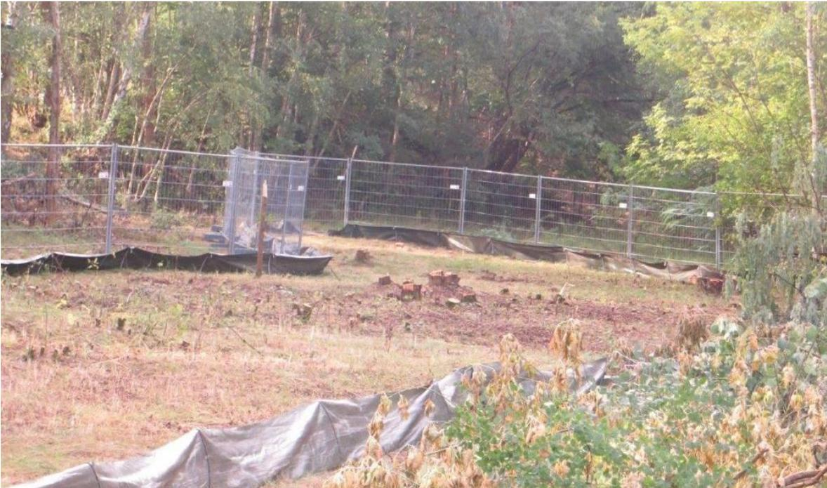
**Abbildung 2-2: Bauzaun als Schutz vor Beschädigung des Schutzzaunes auf einer einem Fußweg zugewandten Seite (LEGUAN GMBH 2016b)**
