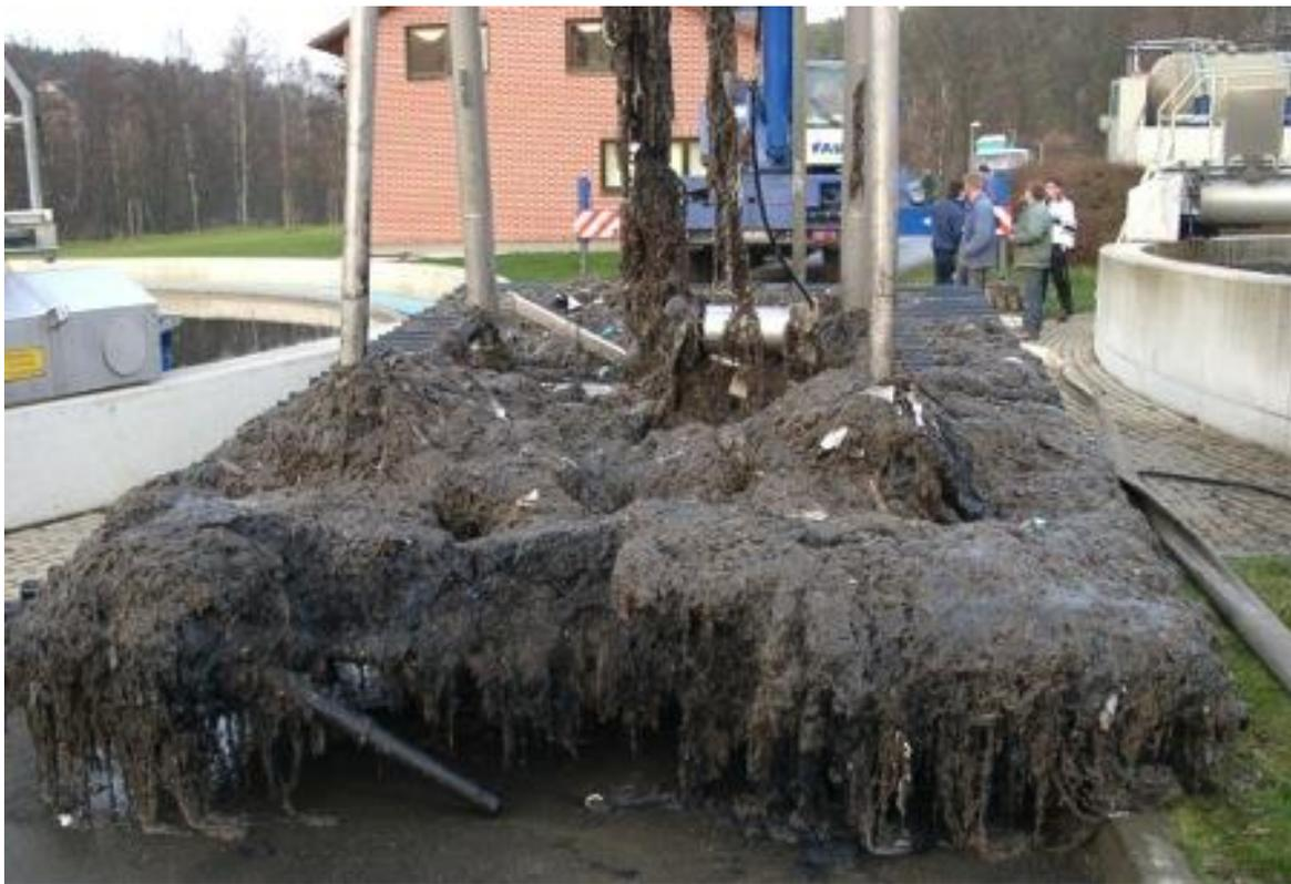
Abbildung 1 Aus Belebungsbecken gehobenes Belüftergitter mit Grobstoffen und Verzopfungen beladen bei einer vergleichbaren Kläranlage (Foto: Nowak)
