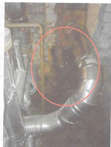
Der Ablauf des Abgaskondenswassers läuft unkontrolliert in die Kellerwand und birgt das Risiko von Gebäudeschäden (Foto2)! **Dies sollte umgehend saniert werden.**
