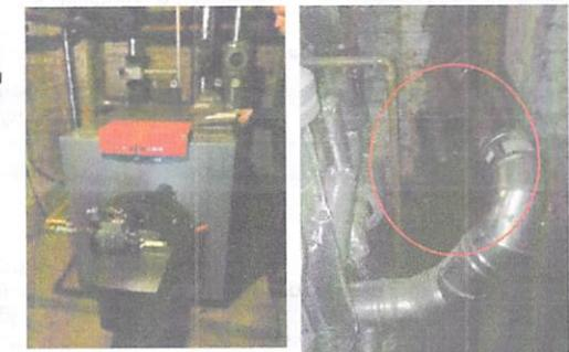
Der Ablauf des Abgaskondenswassers läuft unkontrolliert in die Kellerwand und birgt das Risiko von Gebäudeschäden (Foto2)! Dies sollte umgehend saniert werden
