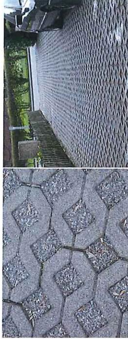
Abb. 6: Anwendungsbeispiel Rasengittersteine mit Splittfüllung
