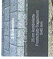
Abb. 7: Aufbau für wasserdurchlässigen Boden im Bereich von leichtem Verkehr, von Zufahrten und von Pkw-Stellplätzen [9]
