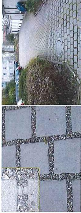
Abb. 5: Beispiel eines Sickerfugensteins mit angeformten Abstandshaltern
