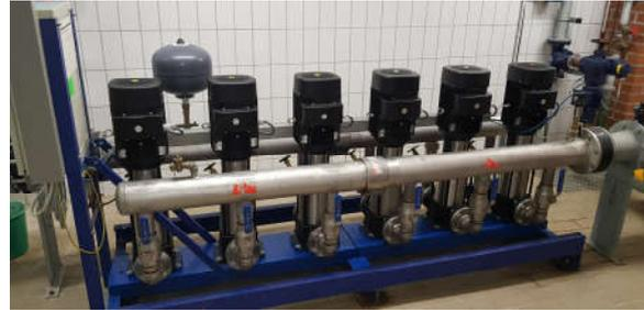
Der Trinkwasserbehälter in Seefeld mit einem Fassungsvermögen von 2 x 200 m<sup>3</sup> wird vom Wasserwerk Werneuchen gespeist. Mit einer drehzahlgeregelten Reinwasserpumpenanlage in Kompaktbauweise werden der südliche Teil von Seefeld sowie das Gewerbegebiet Seefeld und Krummensee mit Trinkwasser versorgt.
