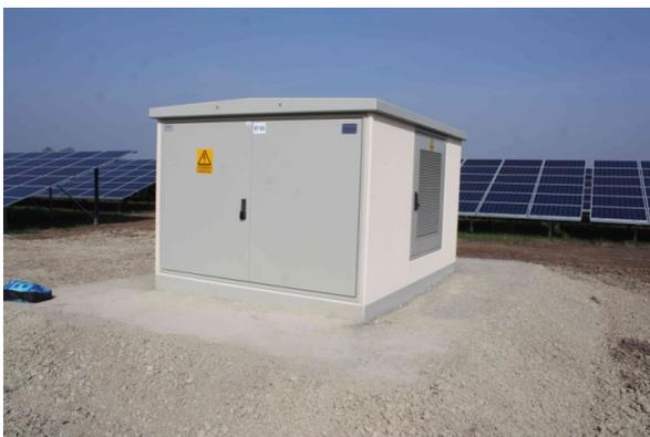
Abbildung 3.6 Beispieldarstellung Trafostation
