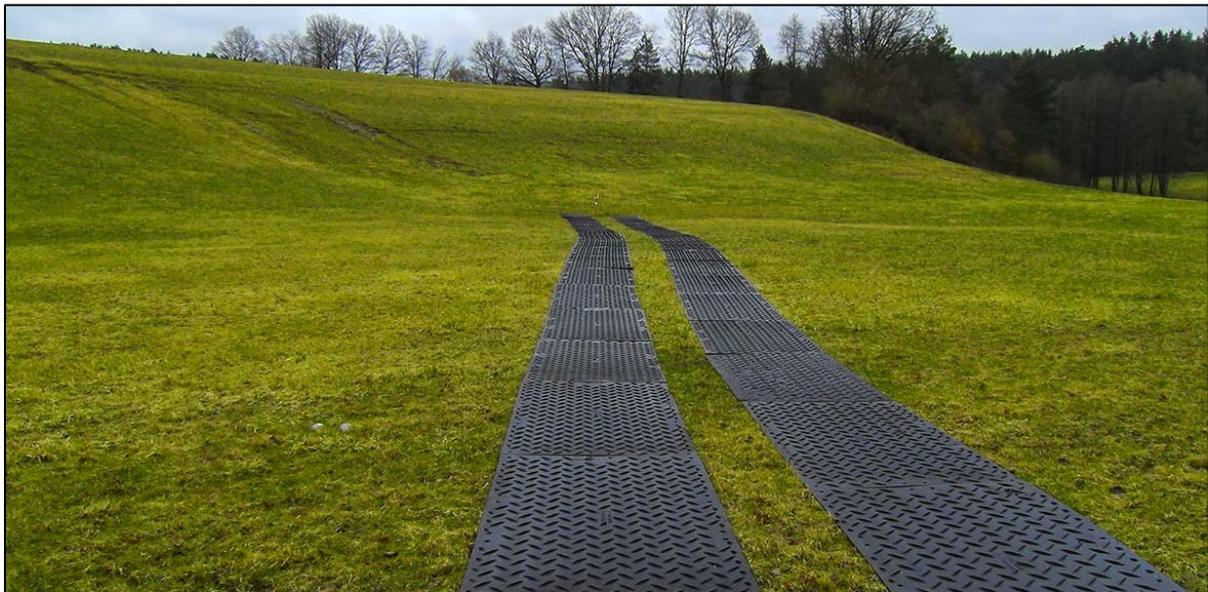
**Abbildung 5:** Beispielfoto mobile Baustraße zur Vermeidung von Bodenverdichtung
